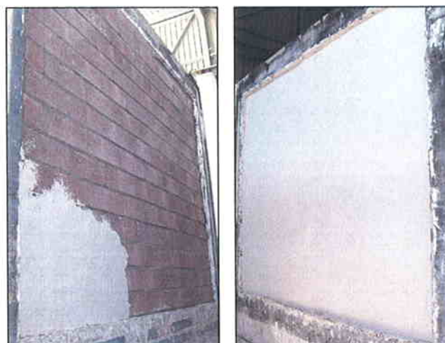
Imágenes 8 y 9 Enyesado de la pared
