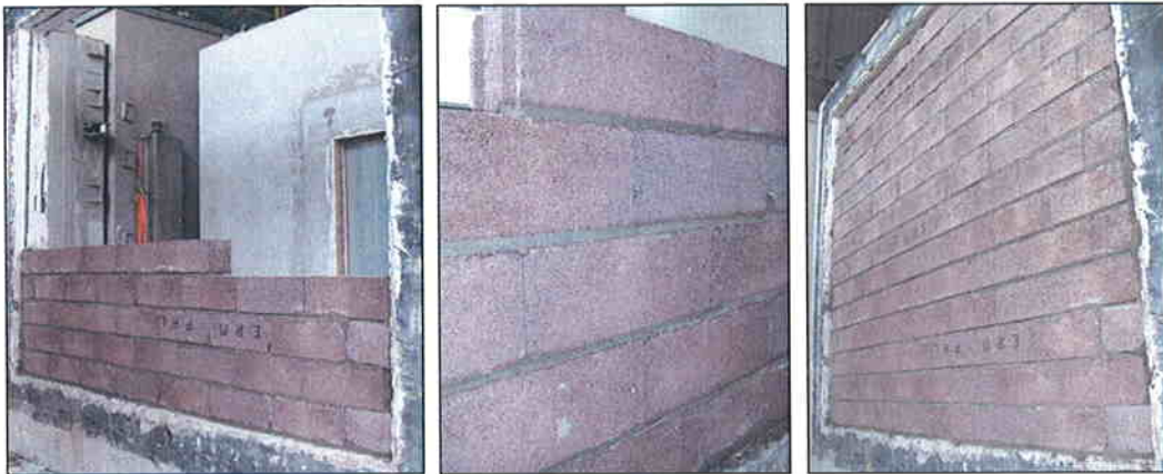
Imágenes 5, 6 y 7 Construcción de la pared de ARLIBLOCK MACIZO 50x20x20
